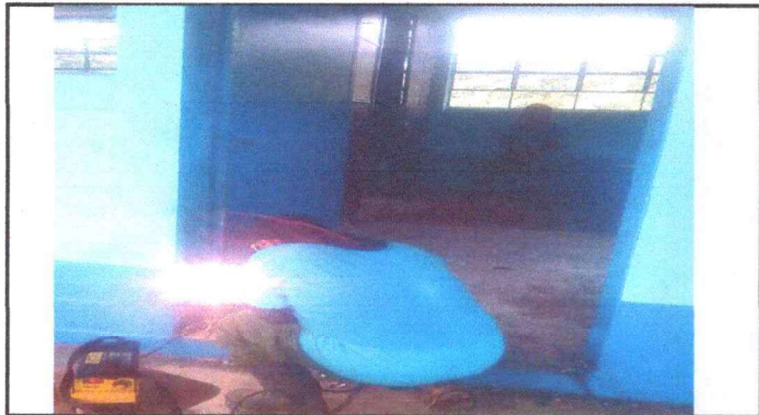
Foto 3: SE ESTAN REALIZANDO LOS CAMBIOS DE LAS PUERTAS.
