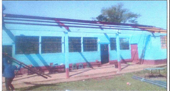
Foto 2: SE ESTAN CAMBIANDO LAS COSTANERAS DE LAS AULAS.
