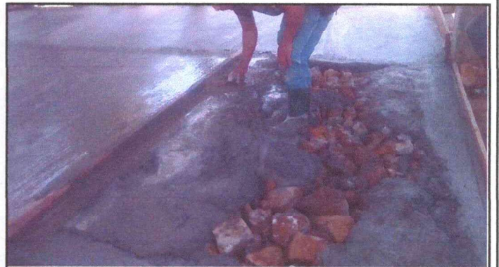
Foto 4: SE ESTA MEJORANDO EL PISO DE LAS AULAS
